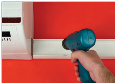
Закрепите основание короба на стене
