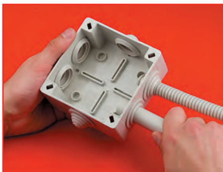
Заводим гофрированную и жесткую трубы
