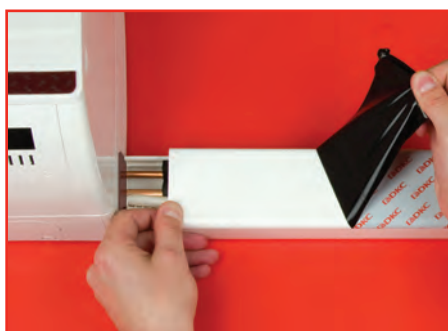
Снимите с крышки защитную пленку
